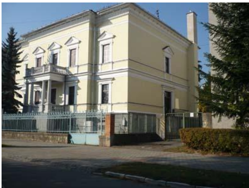
„Petelenova vila“ na Súdnej ulici v Banskej Bystrici, ktorú postavil otec L.F. Hudeca, staviteľ Juraj Hudec
